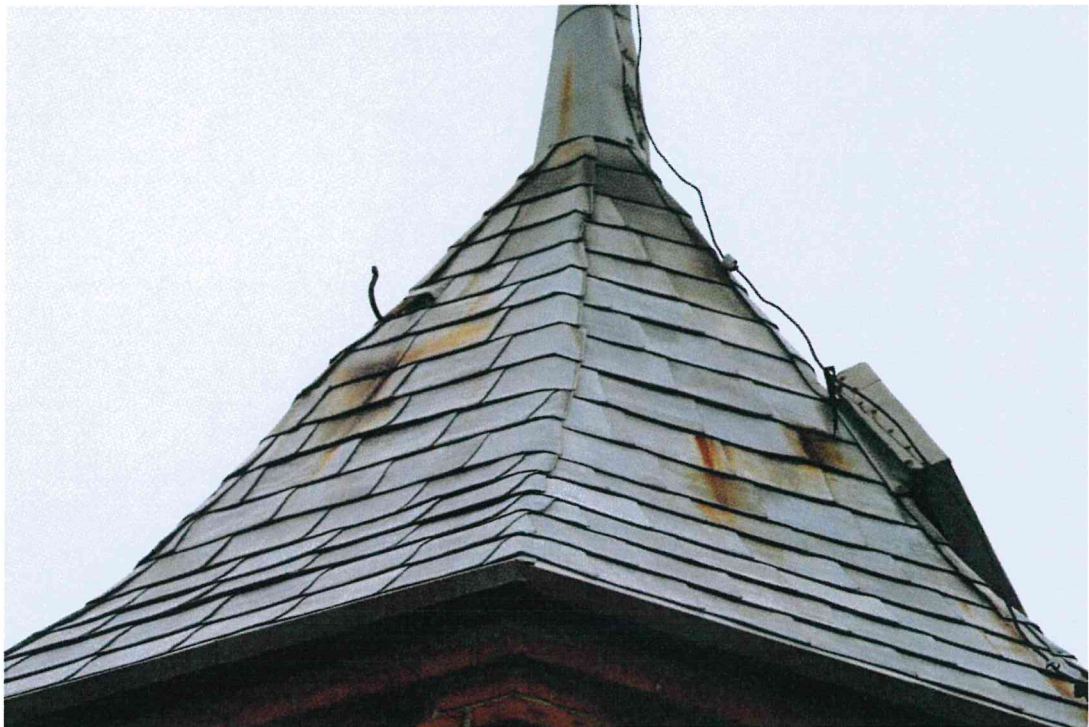
Fotografia 10. Sośno, kościół pw. Niepokalanego Serca Maryi w Sośnie, hełm wieży, widoczne zaplamienia.
