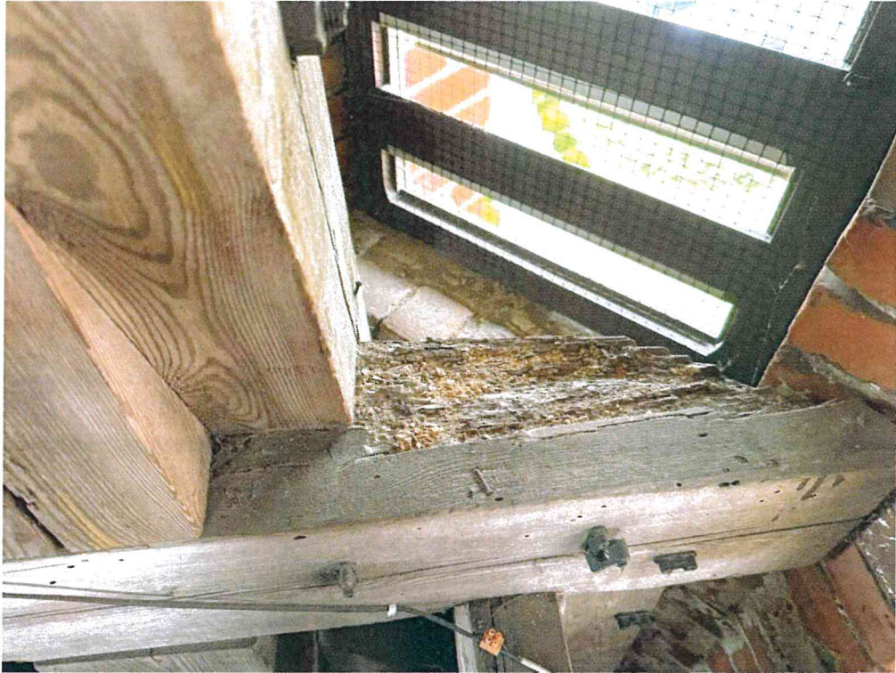
Fotografia 25. Sośno, kościół pw. Niepokalanego Serca Maryi w Sośnie, elementy konstrukcyjne dzwonnicy, widok z III kondygnacji, widoczne ubytki spowodowane działalnością owadów. Fot. A. Kobus.
