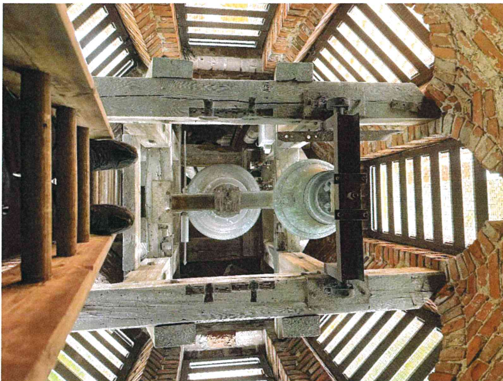
Fotografia 27. Sośno, kościół pw. Niepokalanego Serca Maryji w Sośnie, elementy konstrukcyjne dzwonnicy, widok na III kondygnację. Fot. A. Kobus.
